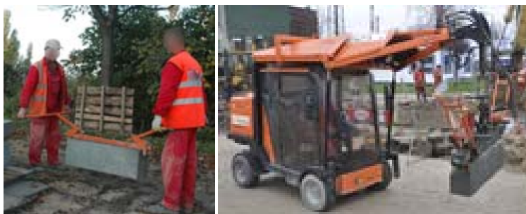
Ryc. 23 Transport ciężkich elementów. Jeszcze lepszym sposobem przemieszczania ciężkich obiektów jest transport zmechanizowany – w tym przypadku betonowych krawężników.
